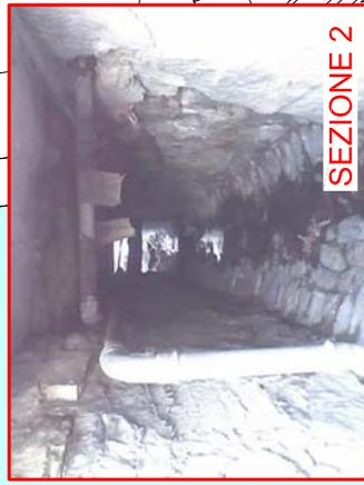
SOSTITUZIONE CONDOTTA ESISTENTE (TC Ø 500 ) CON TUBO IN PE CORRUGATO DN 1030
