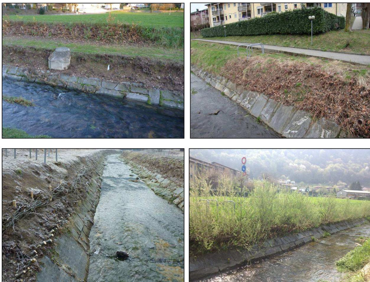
Figura 3 – Sopra: problemi di erosione della sponda dovuti al Poligono del Giappone (stato autunno 2011). Sotto: intervento di consolidamento con tecniche di ingegneria naturalistica (sinistra: posa fascinate di salici autoctoni 2011, destra: stato aprile 2013).
